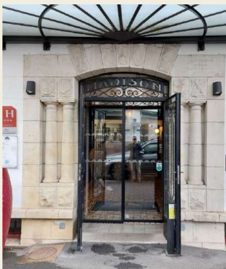
Accès PMR abaissé et porte automatique
