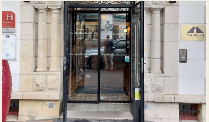
ACCÈS PMR abaissé et porte automatique
